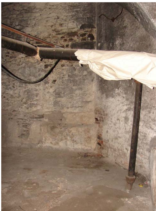
Foto 9: Přízemí, šikmá stěna není provázána s pilířem ani se stěnou u schodiště, tzn., že byla vyzděna dodatečně – viz Příloha 4.1, sonda P5
