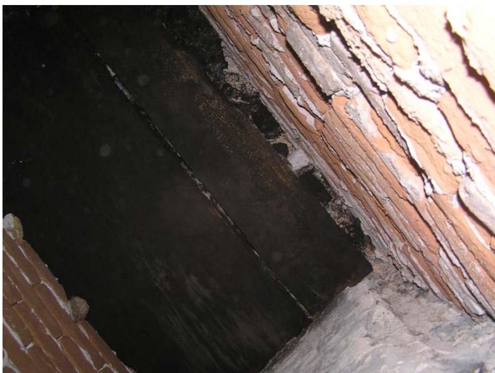
Foto 5: Přizemí, vnitřní stěna u schodiště, původní zazděný otvor ve stěně – viz Příloha 4.1, sonda P3
