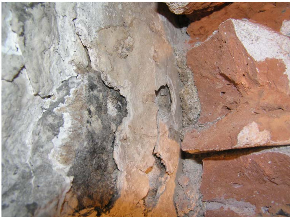
Foto 10: Přízemí, styk šikmé stěny (cihly) s původním zdivem – viz Příloha 4.1, sonda P5
