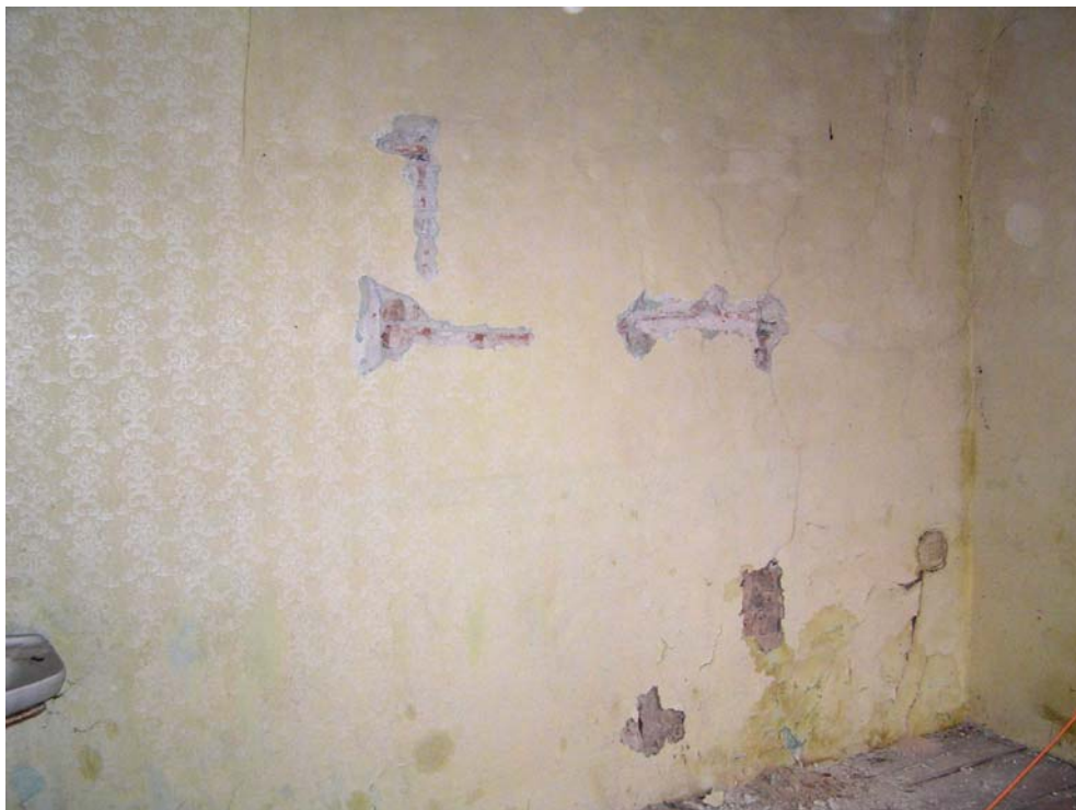
Foto 14: 2. patro, sonda pro zjištění původního zazděného otvoru ve vnitřní stěně (původní otvor potvrzen) – viz Příloha 4.1, sonda P7
