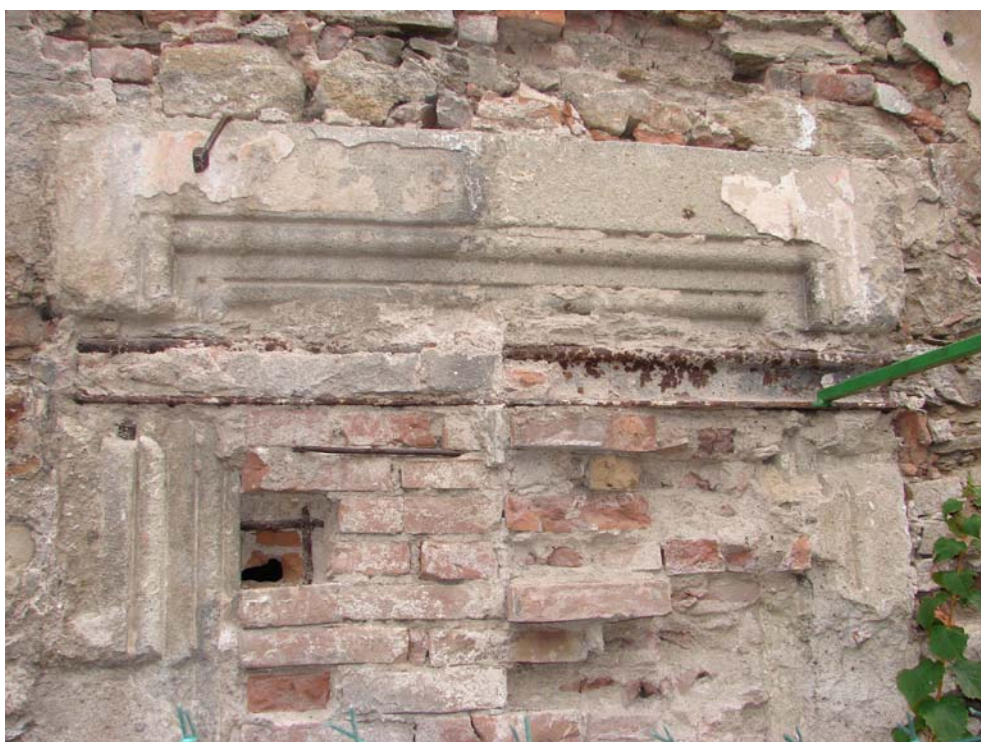
Foto 2: Prizemí, západní obvodová stěna, původní zazděný otvor ve stěně, patrně kolejnice vložená pod původní kamenné nadpraží a dále pravděpodobně původní mříž ve vysekaném otvoru dozdivky – viz Příloha 4.1, sonda P1
