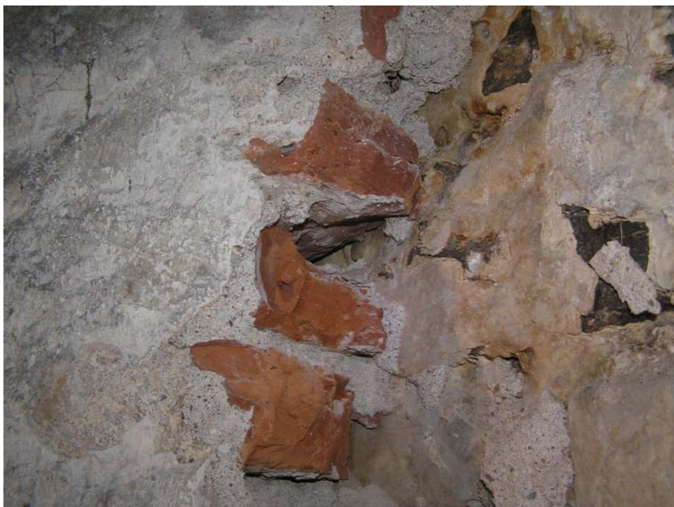
Foto 11: Přízemí, styk šikmé stěny (cihly) s původním zdivem – viz Příloha 4.1, sonda P5
