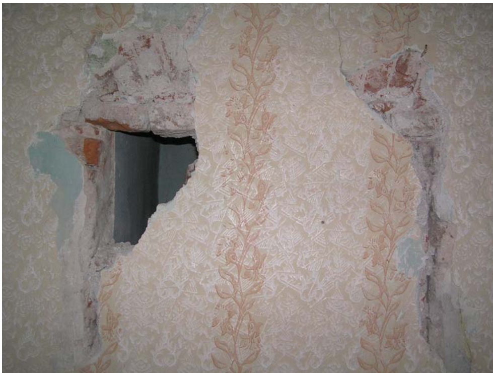
Foto 12: 1. patro, sonda pro zjištění původního zazděného otvoru a schodiště ve vnitřní stěně – viz Příloha 4.1, sonda P6
