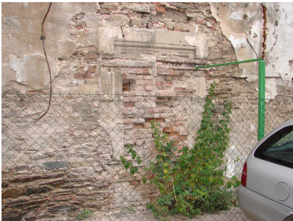
Foto 1: Prizemí, západní obvodová stěna, původní zazděný otvor ve stěně, patrně původní kamenné ostění a nadpraží – viz Příloha 4.1, sonda P1
