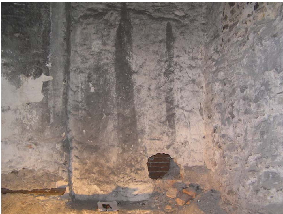
Foto 4: Přizemí, vnitřní stěna u schodiště, původní zazděný otvor ve stěně – viz Příloha 4.1, sonda P3
