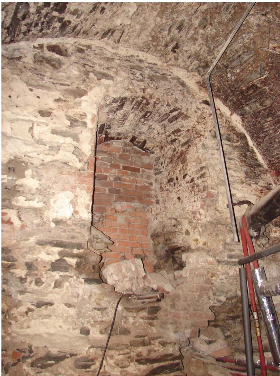
Foto 3: Přízemí, západní obvodová stěna, původní zazděný otvor ve stěně – viz Příloha 4.1, sonda P2
