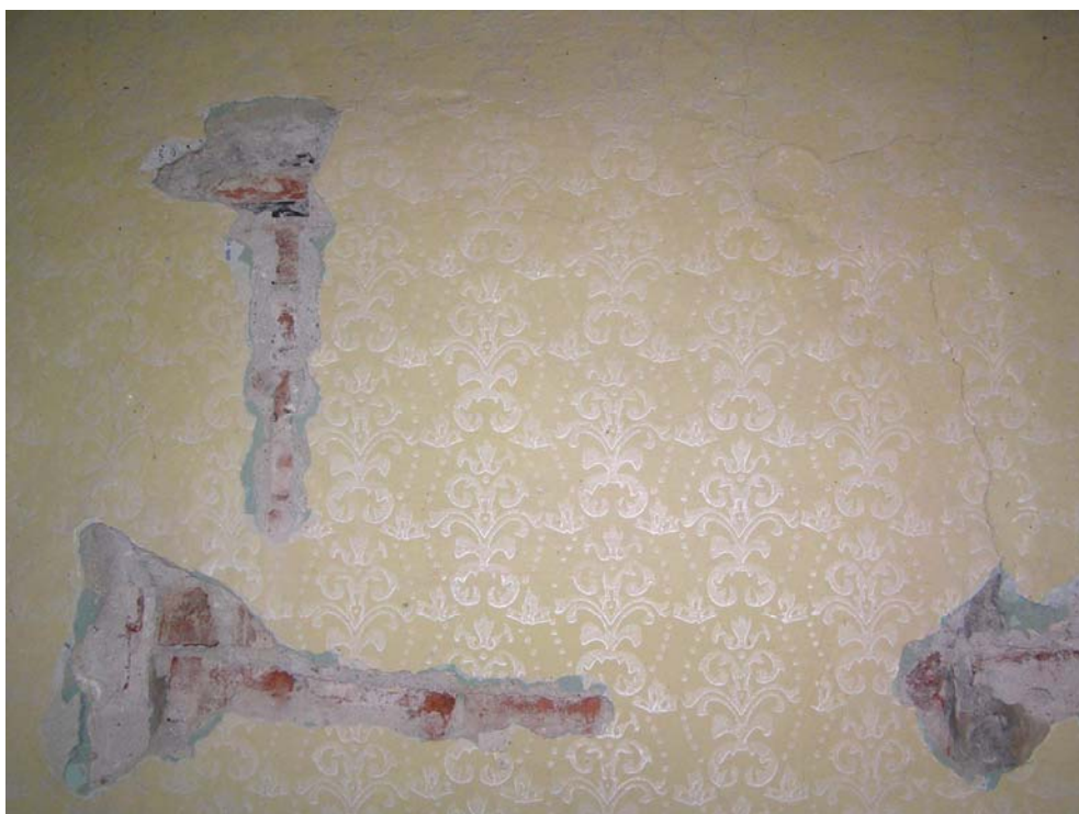
Foto 15: 2. patro, sonda pro zjištění původního zazděného otvoru ve vnitřní stěně (původní otvor potvrzen) – viz Příloha 4.1, sonda P7
