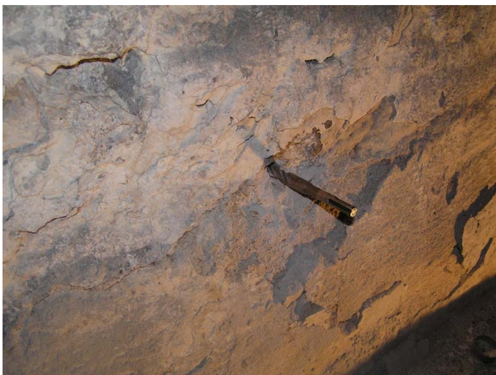
Foto 7: Přízemí, vrt 1 z předchozí fotografie, vrtem do hl. 0,95 m nebyla potvrzena existence dutiny – viz Příloha 4.1, sonda P4
