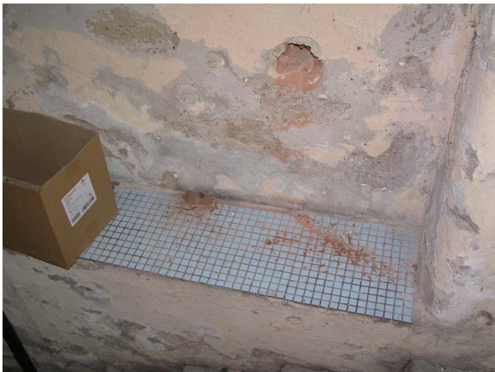
Foto 8: Přízemí, vrt pro zjištění existence dutiny za stěnou u hlavního schodiště, vrt 2 – viz Příloha 4.1, sonda P4
